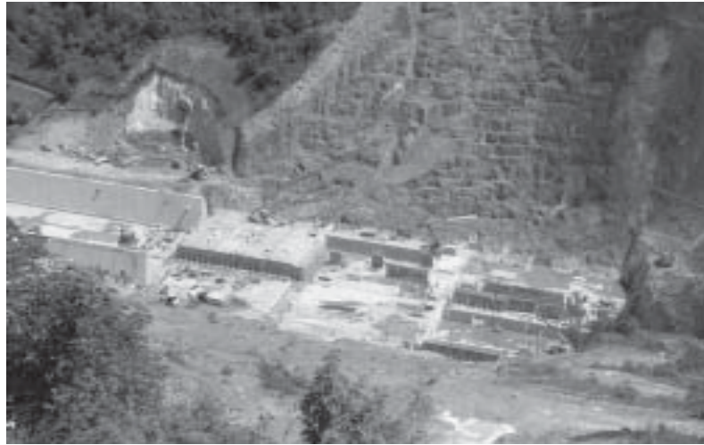
Nach Jahren intensiver Debatten ist jetzt der Damm der Talsperre Leibis im Bau. Foto: Thüringer Talsperrenverwaltung
